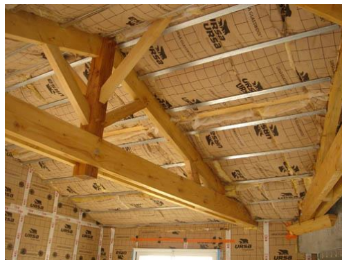
Aides en faveur de l'isolation des toitures Crédit-photo : CCRM
