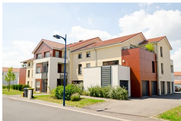
Lotissement « Les terrasses » à Ennery
